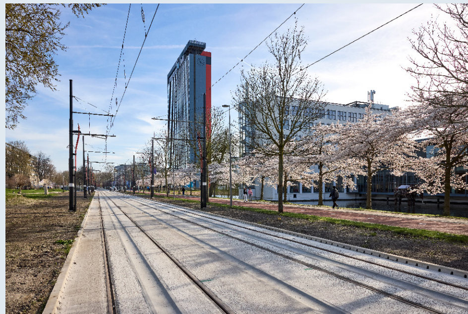
Aanleg tramlijn 19 in TU-wijk Delft. Foto: Vincent Basler
