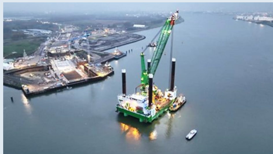
Aanleg tunnel in de Blankenburgverbinding. Foto: Rijkswaterstaat
