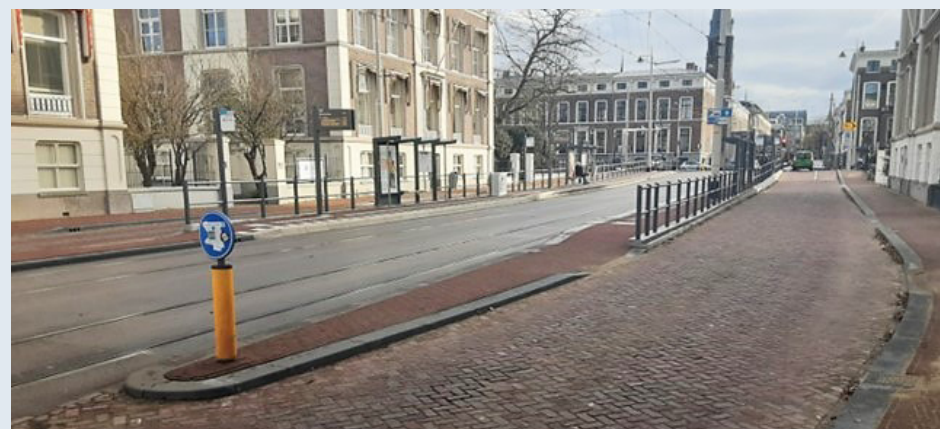
Aangepaste tramhalte Mauritskade in Den Haag
