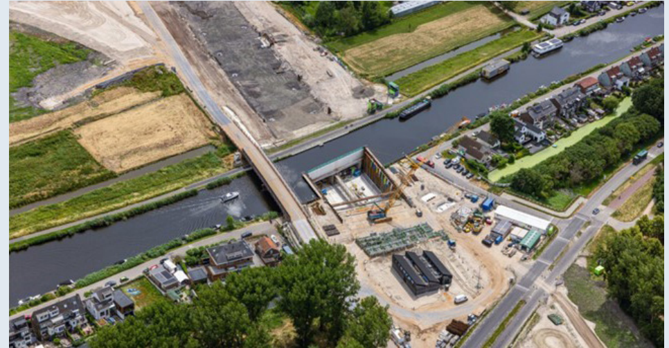
Aanleg tunnel onder de Rotte. Foto: Rijkswaterstaat
