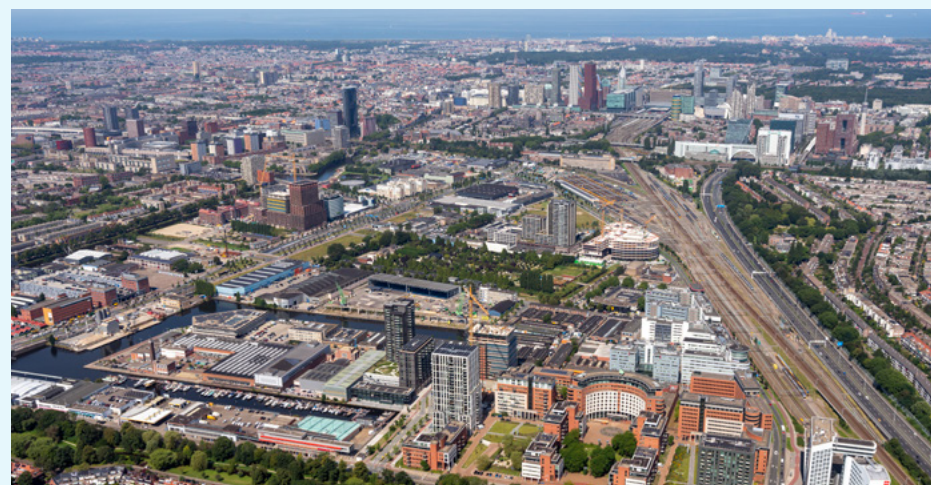
CID-Binckhorst met op de achtergrond station Den Haag Centraal. Foto: Jurriaan Brobbels
