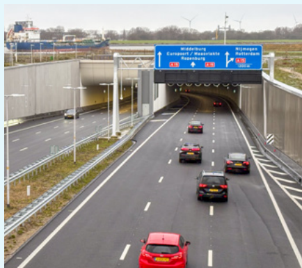
Maasdeltatunnel, gezien vanaf het noorden. Foto: Rijkswaterstaat
