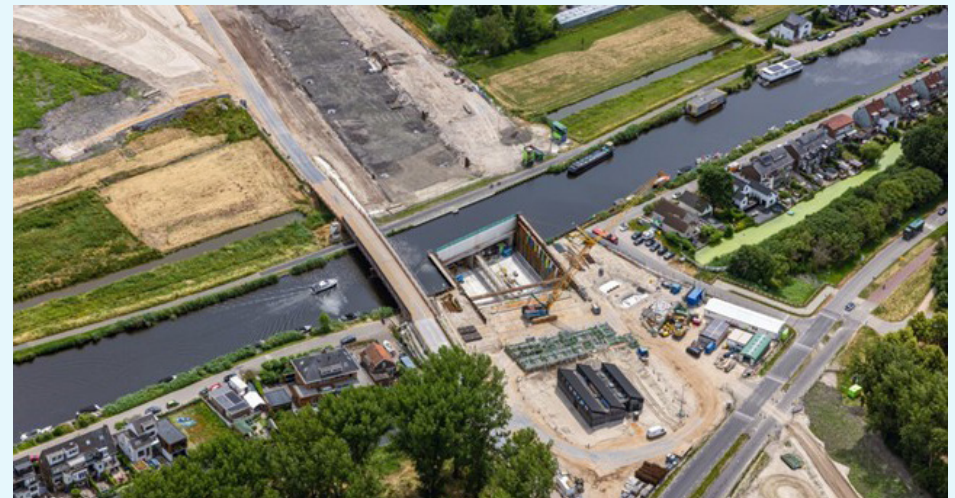
Aanleg tunnel onder de Rotte. Foto: Rijkswaterstaat
