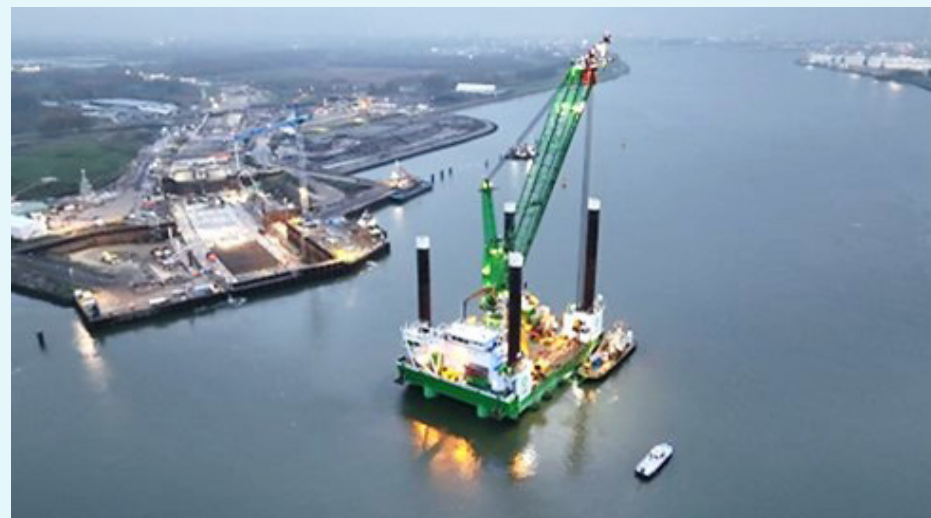
Aanleg tunnel in de Blankenburgverbinding. Foto: Rijkswaterstaat
